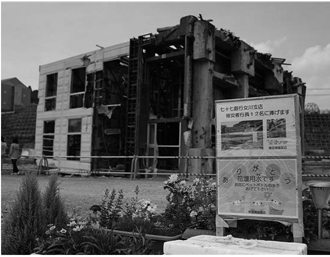
4階建ての七十七銀行屋上に避難したが12名が犠牲となった。横倒しのビル前の花壇には桔梗が植えられ「ペットボトルの水をあげてください」と記されている。
