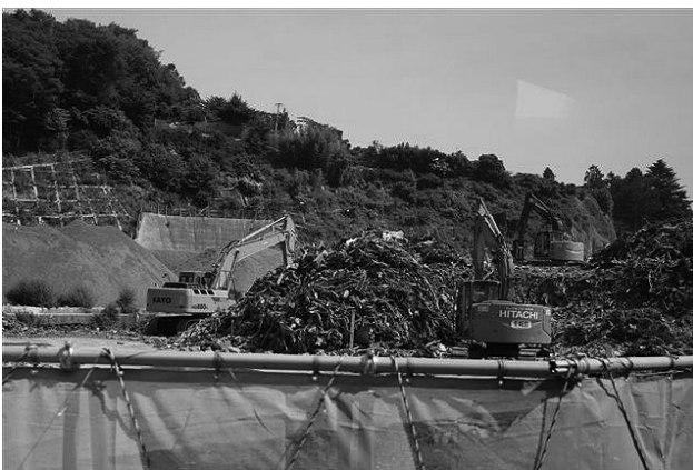
山のように積み上げられたガレキの区分作業はまだまだ続く
